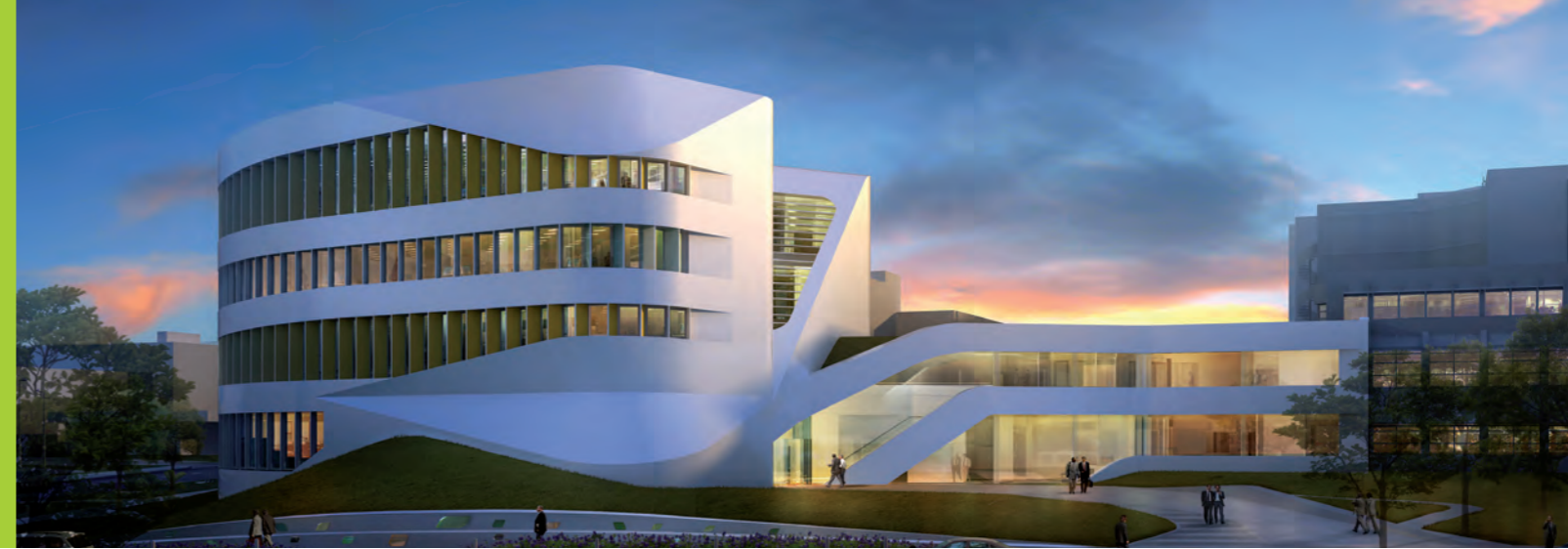
Abbildung 17: Zentrum für Virtuelles Engineering am Fraunhofer IAO mit DGNB-Vorzertifizierung (Quelle: Fraunhofer IAO/IUN Studio AS-PLAN).
